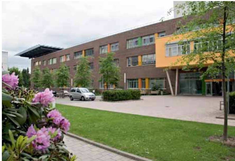
Neubau mit Hubschrauberlandeplatz auf dem Dach
