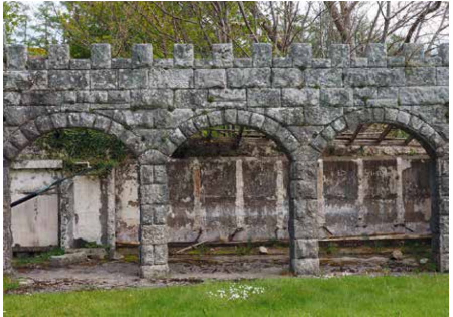
Ehemalige Waschräume im Freien
